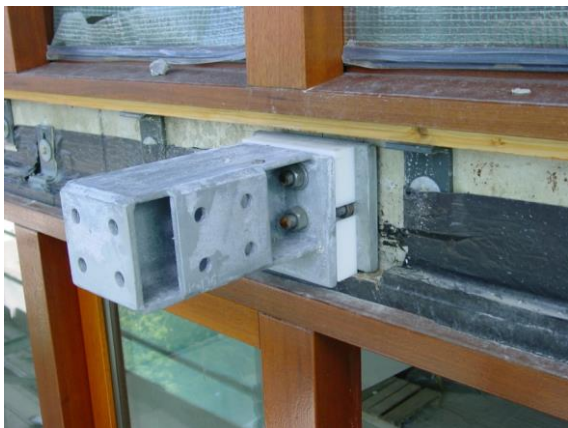
Afbeelding 5 – Detailopname geveldoorvoering
